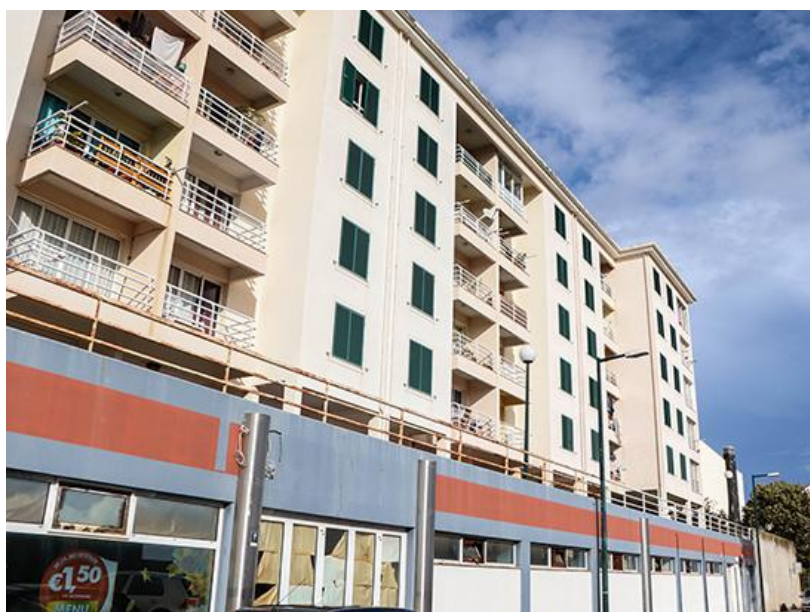
Figura 5. Empreendimento das Figueirinhas
