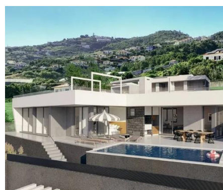
Moradia - Nova Construção
